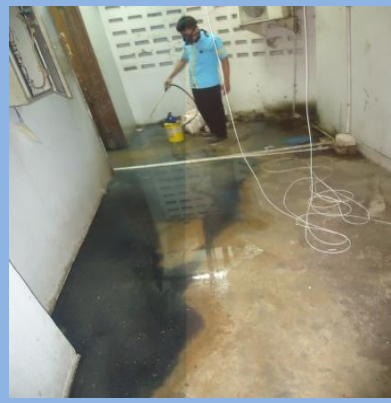
penyemprotan genangan air area basement sisi tower aster
